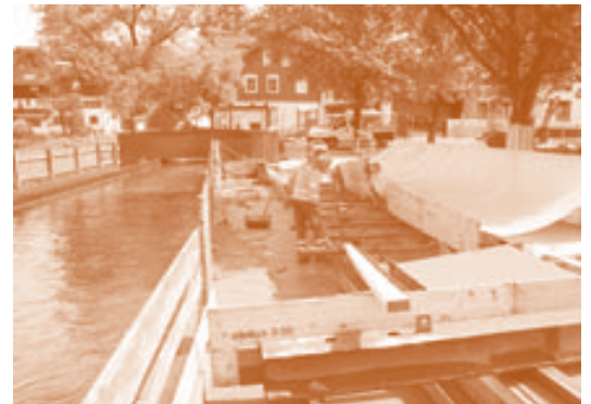
Bauarbeiter beim Gießen der Betonfläche.
